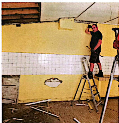
Travail en interne des agents pour diminution des coûts, ici sur un futur logement
